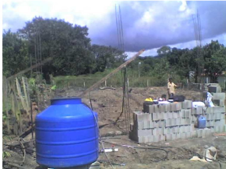
Fotografía 3. Levantamiento de las paredes
