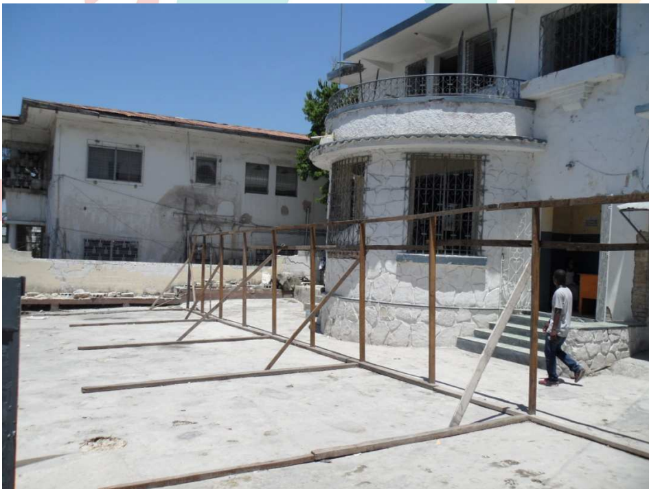
Foto 2.- (El jardín del frente de la universidad con la estructura del espacio que queda para los cursos después del terremoto).
