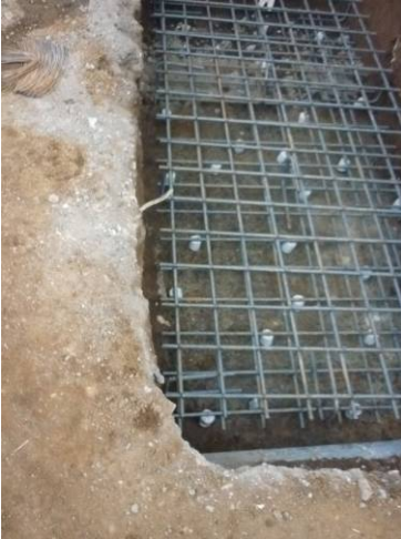
Armadura colocada
