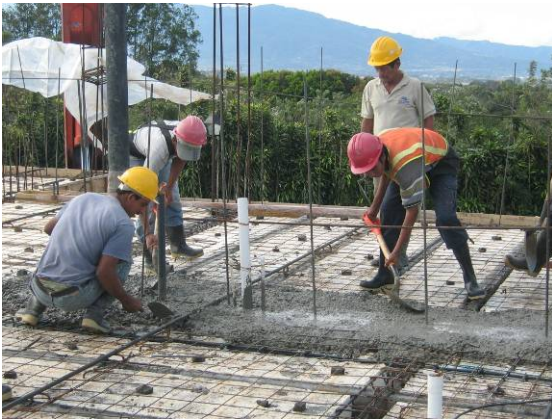
Colocación de mallas, armaduras y dados chorrea de losa con bomba
