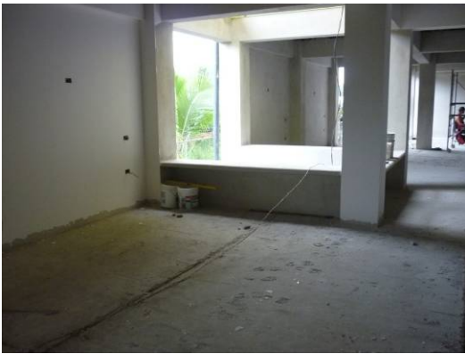
Chorrea de columnas y repellos
